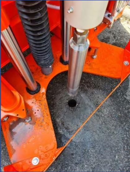
Kernbohrgerät mit 70mm Bohrkronen
